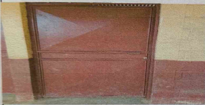
Foto 3: Sustitucion de puertas por mal estado
