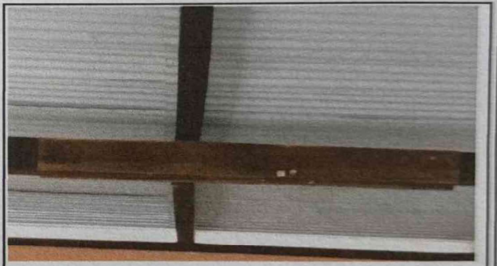
Foto 4: Sustrucion de carga lamina de madera por metalica
