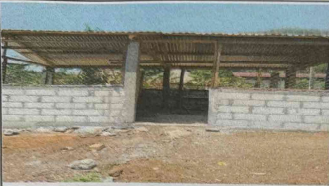
Foto 1: Sustitucion de puertas de cocina por metal
