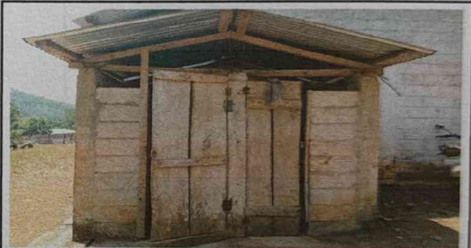
Foto 4: Sustitucion de puertas de madera de baño por metal
