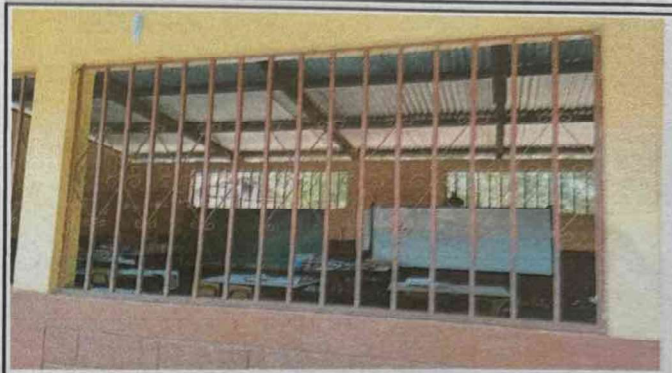
Foto 2: Sustitucion de balcones por mal estado
