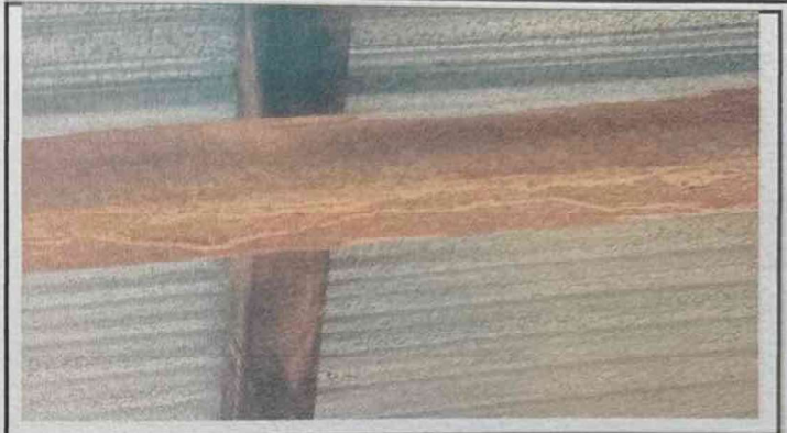
Foto 2: Sustrucion de carga lamina de madera por metalica
